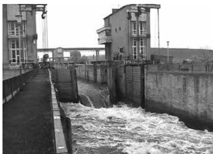
Рис. 2. Авария на шлюзе Константиновского гидроузла. Прорыв напорного фронта при отсутствии аварийных ворот
