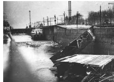
Рис. 3. Авария на западной нитке Пермского шлюза. Прорыв напорного фронта предотвращен с помощью аварийных ворот
