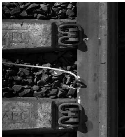
Рис. 2. Состояние заземляющих устройств: изображение с камеры контроля
