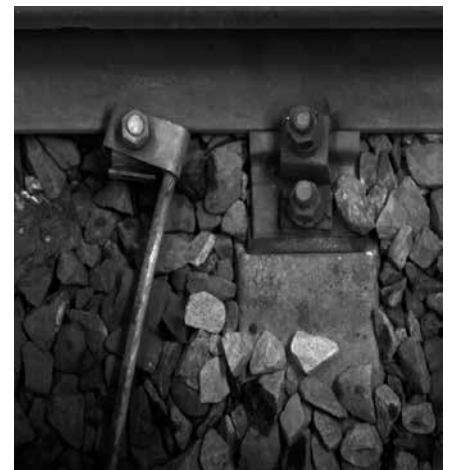
Рис. 2. Состояние заземляющих устройств: изображение с камеры контроля
