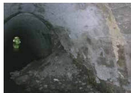
Рис. 2. Состояние водопропускной трубы
