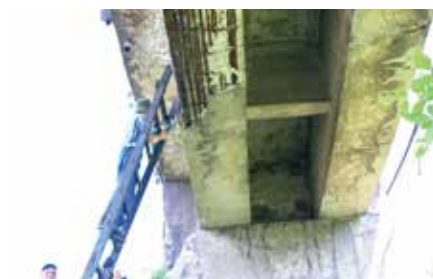
Рис. 1. Железобетонное пролетное строение одного из металлургических комбинатов
