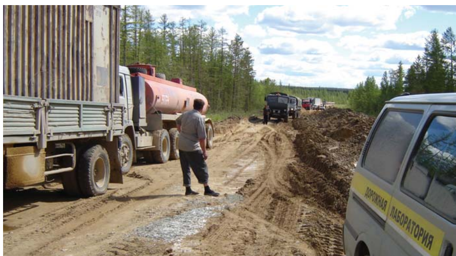
Федеральная дорога Большой Невер – Якутск в период строительства железной дороги на Якутск (2006 г.)
