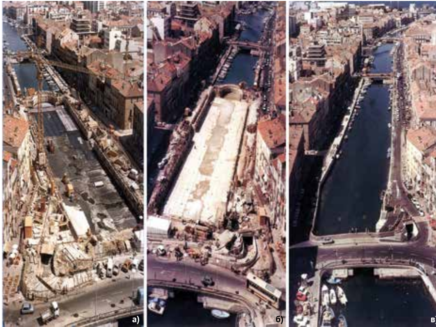
Рис. 7. Устройство двухэтажного паркинга ниже дна реки в пригороде Парижа; а) устройство гидроизоляции перекрытия паркинга (вода реки временно пущена через трубу); б) укладка защитных плит – искусственного дна реки; в) строительство завершено, о нём напоминают только въездные порталы паркинга (Soletanche-Bachy)
