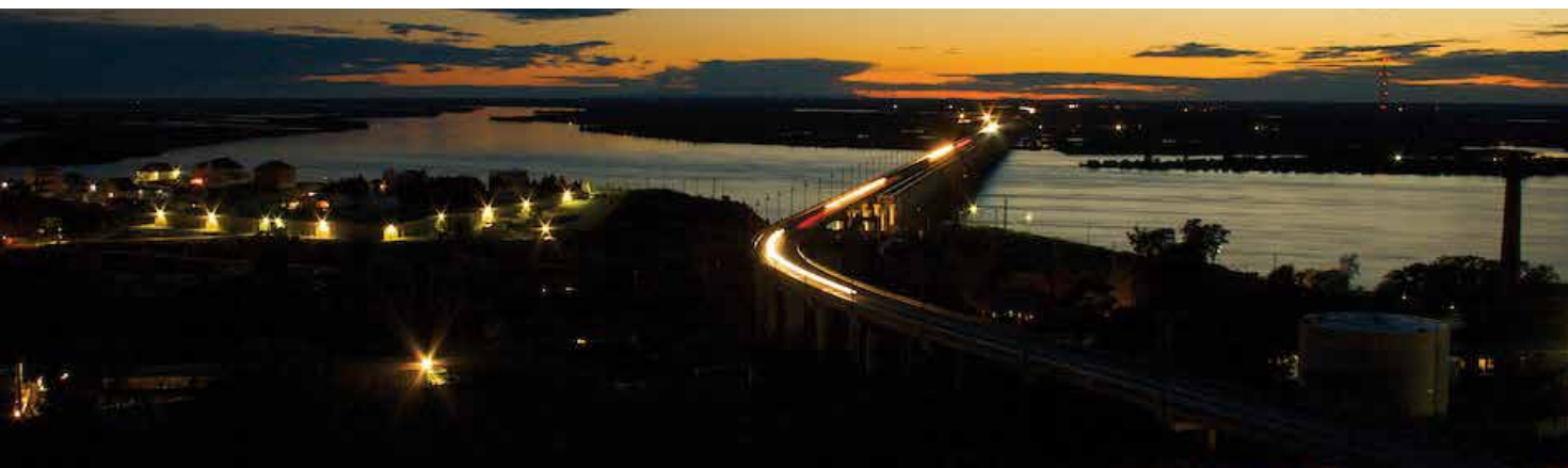
Рис. 1. Мостовой двухуровневый переход через р. Амур
