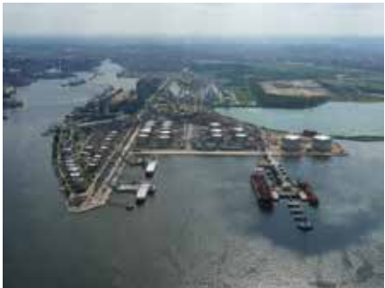
Рис. 6. ЗАО «Петербургский нефтяной терминал» и ОАО «Балтийский Балкерный Терминал»
