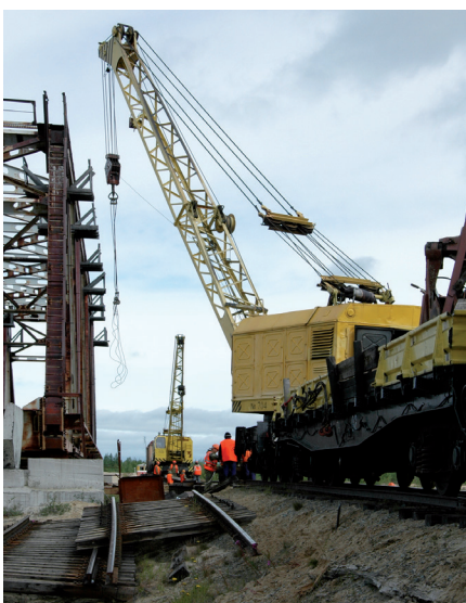
Путевые работы на перегоне Пангоды – Надым- Пристань
