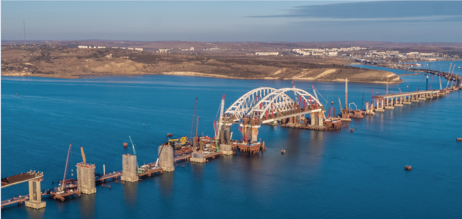
Рис. 2. Строительство моста через Керченский пролив
