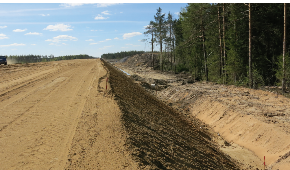
Рис. 1. Земляное полотно автомобильной дороги
